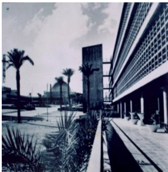
Fotografía del reactor nuclear de Dimona tomada por Mordechai Vanunu.
